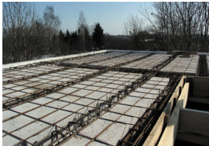
Вариант перекрытия с балками, перевязанными с арматурой верхней стяжки, обеспечивает максимальную прочность. Проект 1231-0
