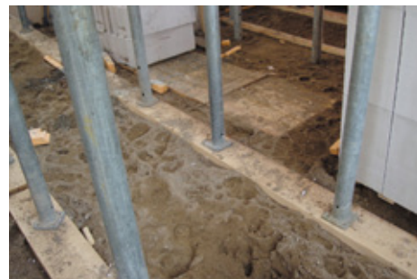
Если фундамент ленточный, особенно важно обеспечить прочность основания под опалубку перекрытий
