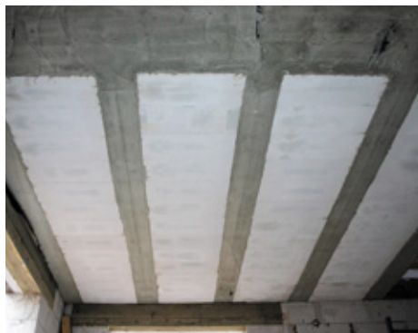
В итоге балки перекрытий и блоки газобетона образуют монолитную поверхность потолка без швов
