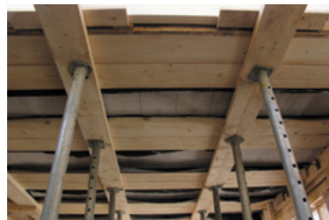
Залог качества перекрытий – точность и аккуратность при устройстве опалубки
