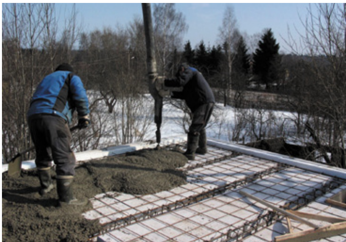
При выполнении заливки бетоном важно соблюдать аккуратность и недопускать смещения блоков
