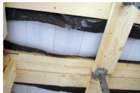
Доски опалубки защищаются плотным полиэтиленом и затем могут использоваться, например, для стропильной системы дома
