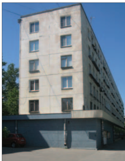
Фото 1. Здание из автоклавного газобетона, 1960-е. Санкт-Петербург, Краснопутиловская, 45.
